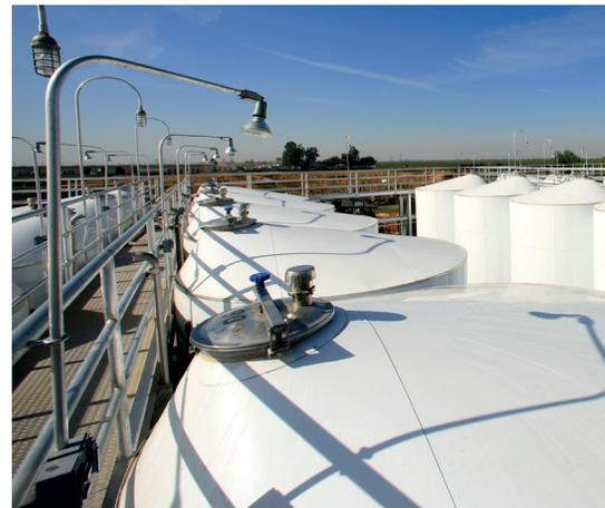
“El aislamiento de los tanques nos permite enfriar rápidamente y mantener fácilmente la temperatura óptima del vino en cualquier clima. Debido a que aislamos aproximadamente el 20% de nuestros tanques exteriores cada año, en los últimos cinco años hemos experimentado una notable reducción en nuestra factura energética de PG&E para el mismo periodo de tiempo”.
